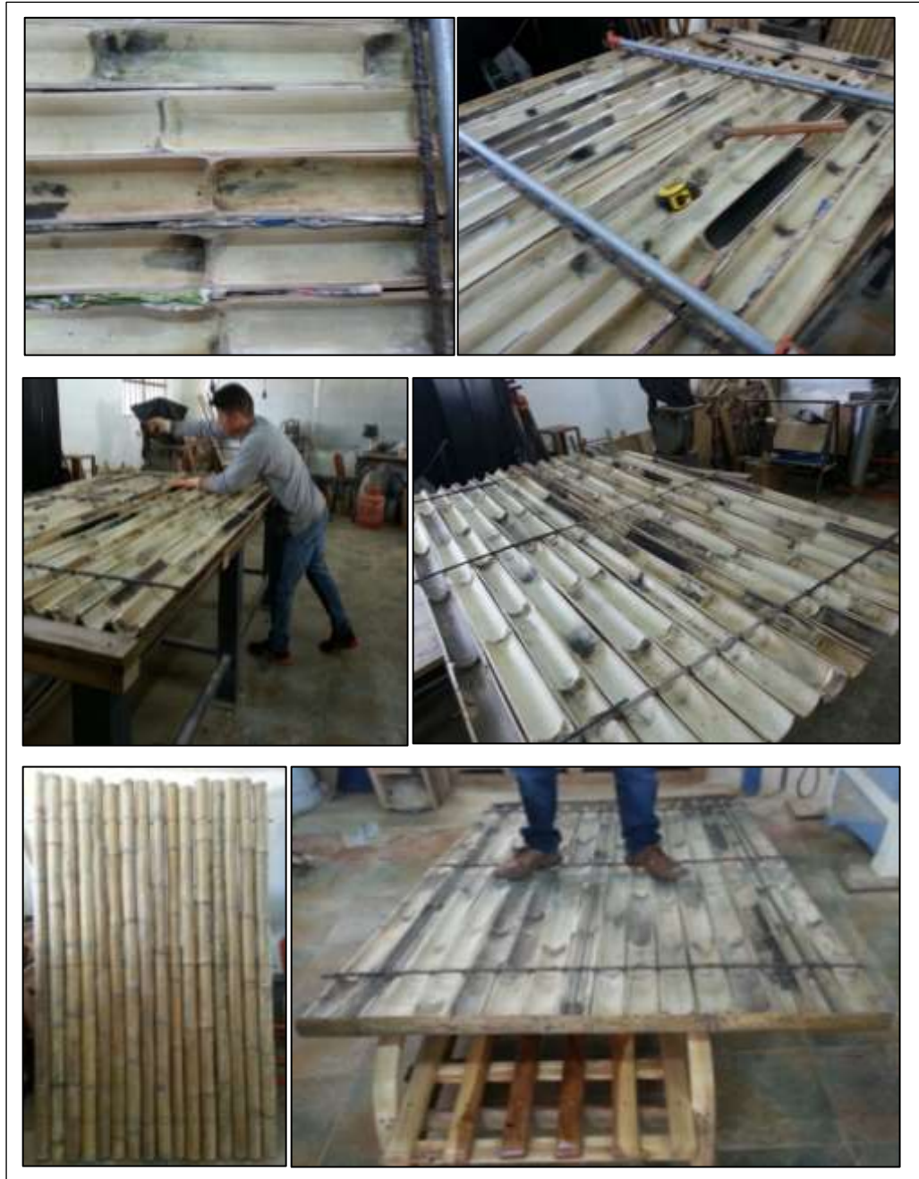
Figura 29. Colocación del refuerzo longitudinal y transversal
