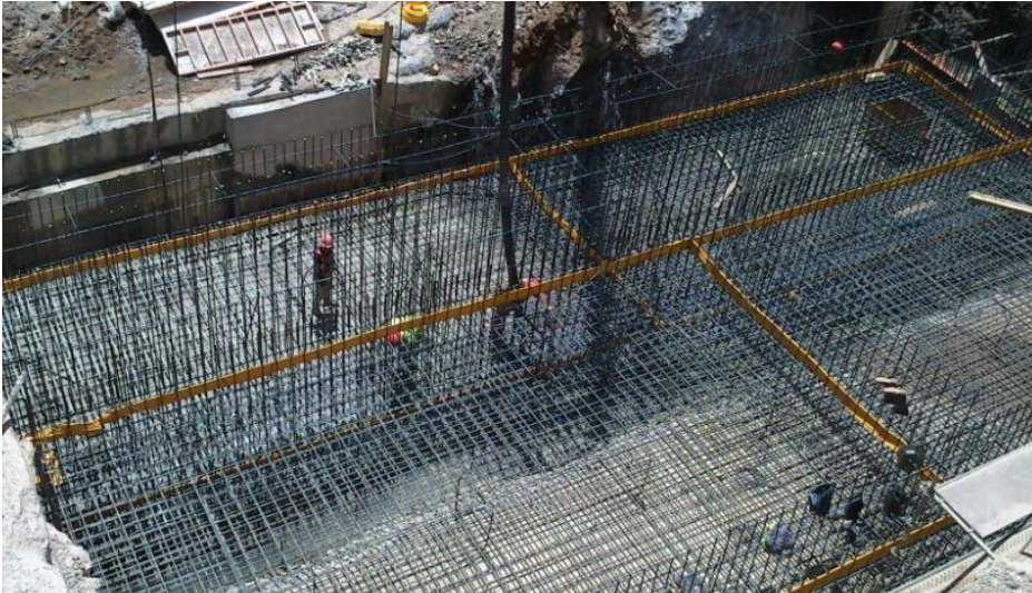
Figura 6. Armado de cimientos
