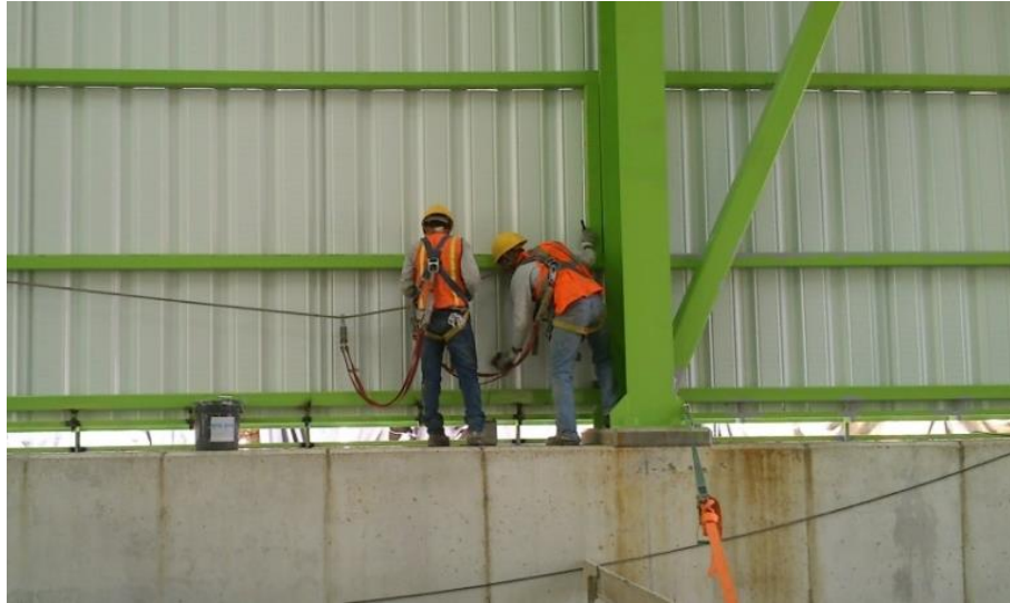
Figura 7. Instalación de cubiertas laterales
