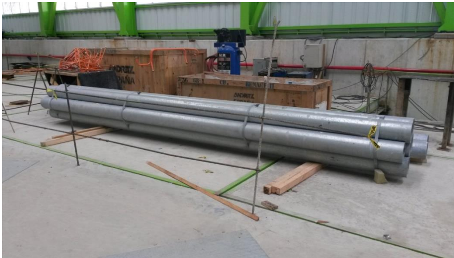
Figura 41. Tubería de acero galvanizado
