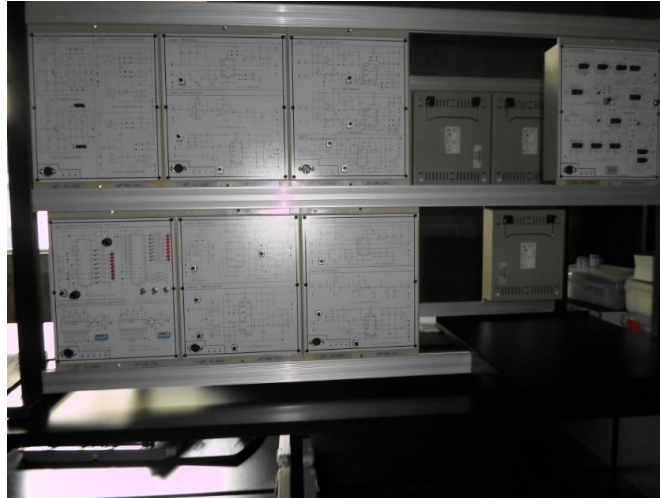
Figura 23. Laboratorio de Telecomunicaciones
