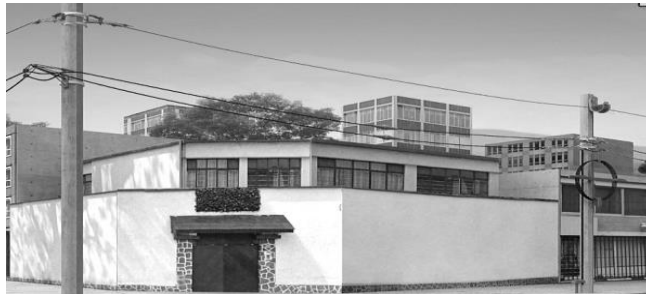
Figura 32. Herrajes de sugesión instalados
