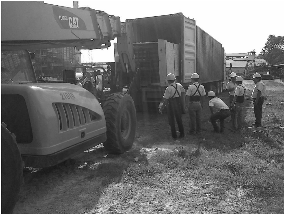
Figura 21. Descarga de materiales de torre de enfriamiento
