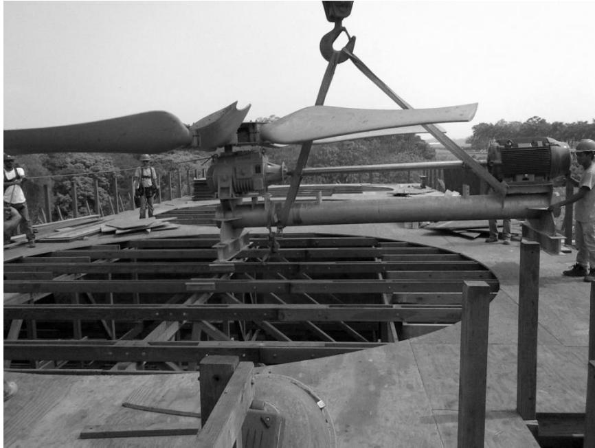
Figura 23. Montaje de equipo mecánico
