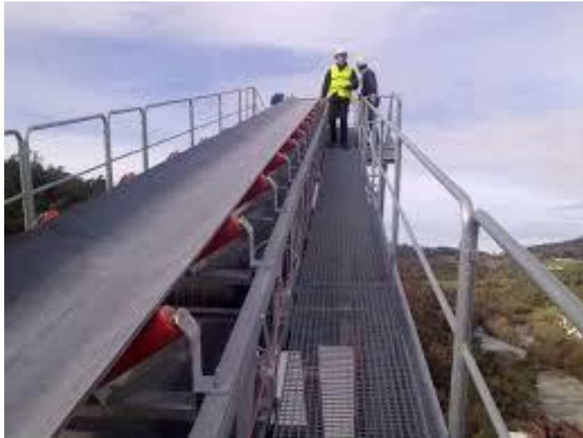
Figura 30. Accesos para mantenimiento
