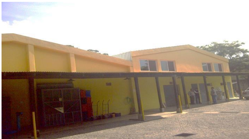
Figura 3. Edificio de producción y administración
