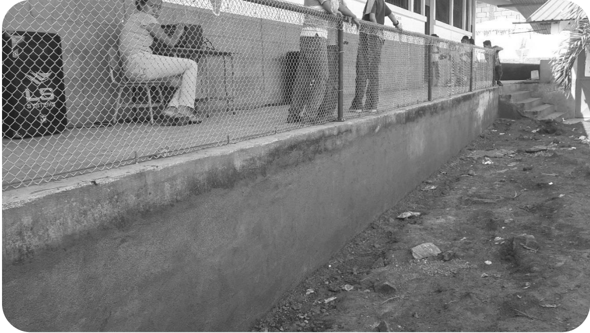
Fotografía 9. Colocación de malla.
