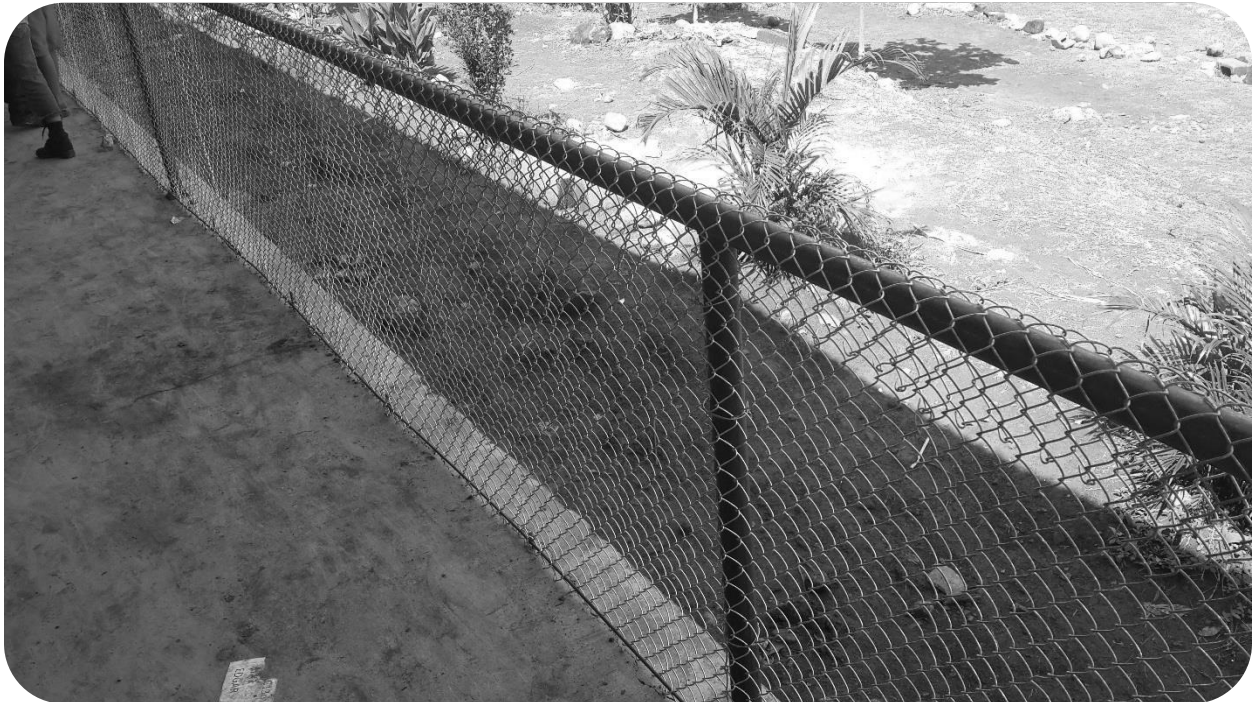
Fotografía 10. Finalización del proyecto comunitario, Baranda de protección en el corredor de la Escuela Oficial Rural Mixta, Lotificación Perú
