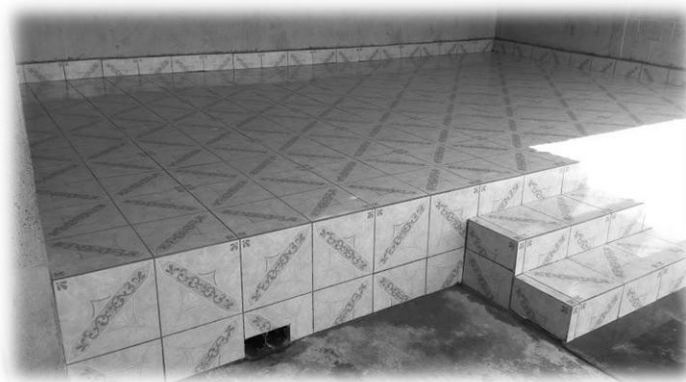
Fotografía No. 4. Azulejo colocado en área de patio de la EOUM Los Almendros.
