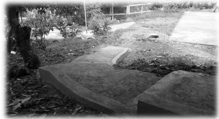
Fotografía No. 7. Gradas colocadas en la EOUM los Almendros.
