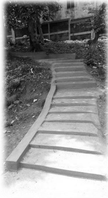
Fotografía No. 9. Trabajo final de colocación de gradas en la EOUM Los Almendros.
