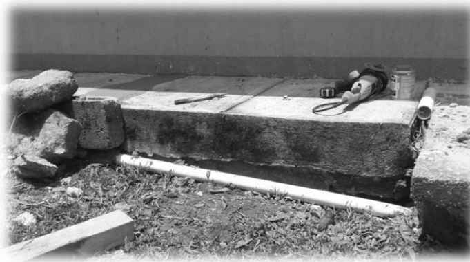
Fotografía No. 13. Nueva tubería del desagüe que se colocó.
