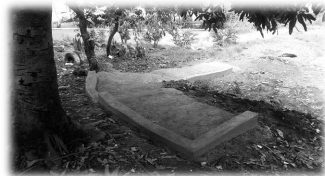
Fotografía No. 8. Gradas colocadas en la EOUM los Almendros.
