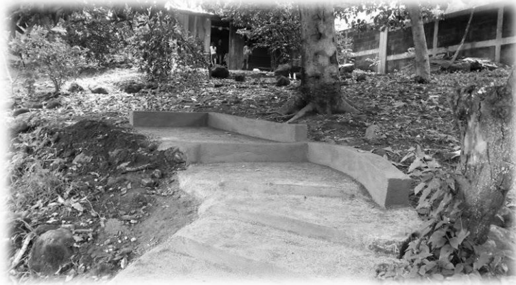
Fotografía No. 6. Gradas colocadas en la EOUM los Almendros.
