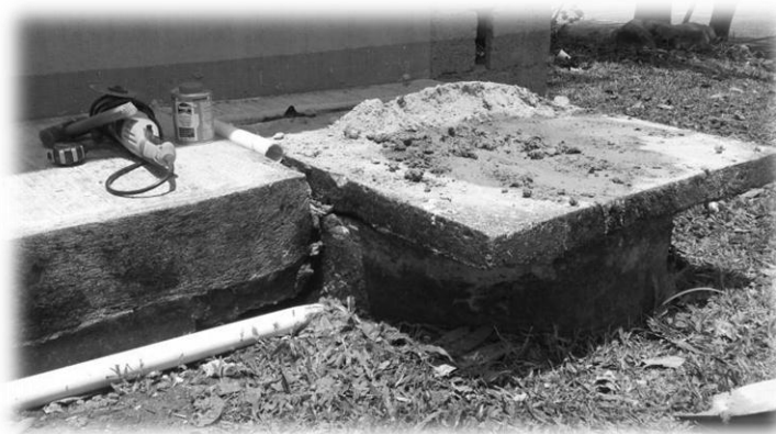
Fotografía No. 14. Depósito de aguas negras donde se depositará la suciedad de la nueva tubería.
