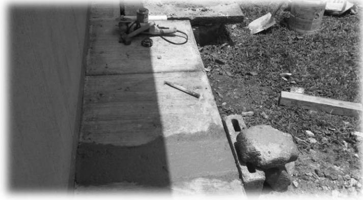
Fotografía No. 15. Estado final de la reparación de la tubería de la clínica dental.
