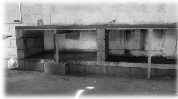
Fotografía No. 3. Construcción de una repisa dentro del aula de 6to. grado de la EOUM Los Almendros.
