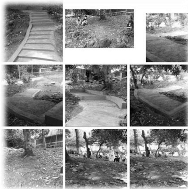
Fotografía No. 5. Serie de fotografías que muestra el antes y después de la colocación de las gradas en la EOUM Los Almendros.
