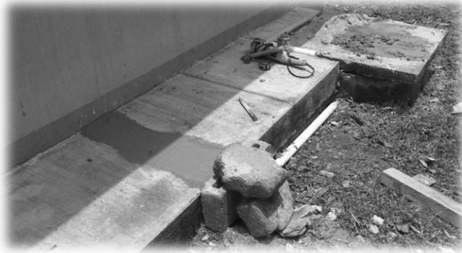
Fotografía No. 12. Vista exterior de la clínica donde se rompió la banquetta y se colocó una nueva tubería de desagüe.
