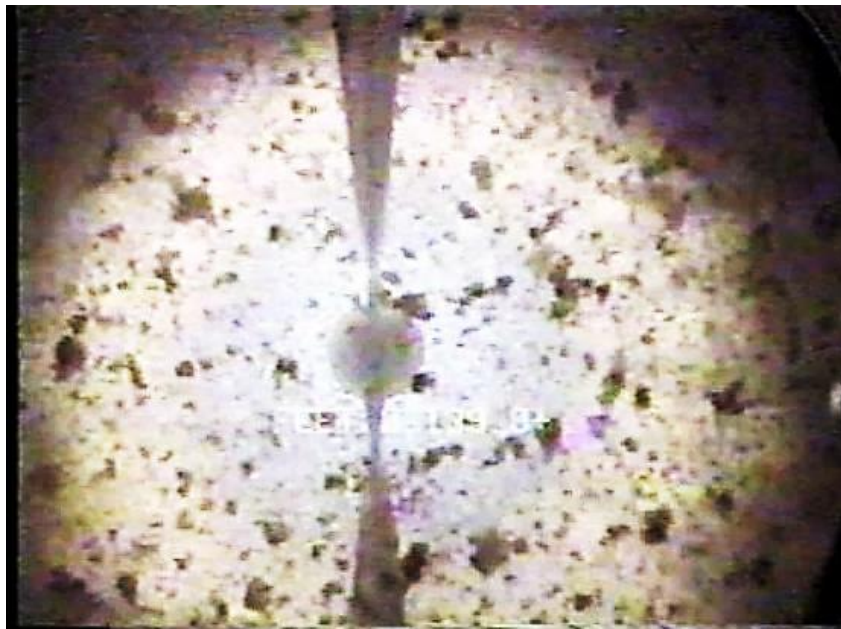
Figura 6. Condición del pozo antes de la rehabilitación
