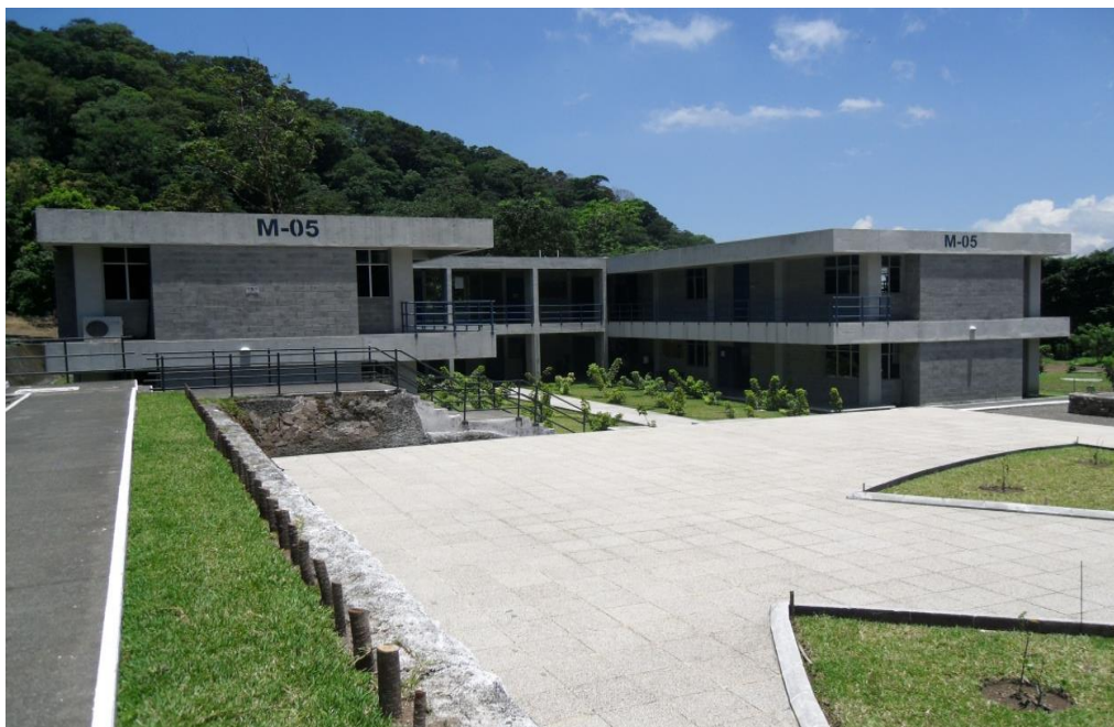
Figura 11. Módulo 5 donde se ubicará el centro de documentación
