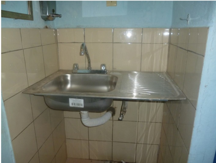
Ya instalado el lavatrastos en la clínica dental
