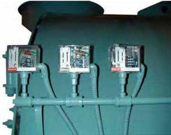
Fuente: *Manual de operación, servicio y partes CB. Presostatos de control de vapor.* p. 15.
