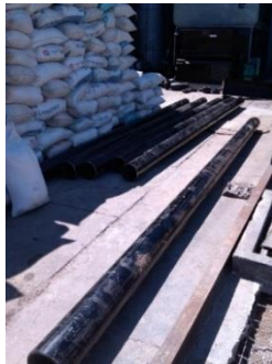
Figura 60. Tubos usados en red de aceite térmico
