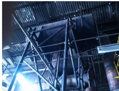
Figura 86. Tanque de expansión
