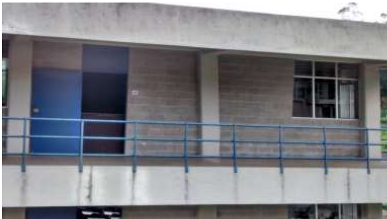
Figura 9. Ubicación del almacén
