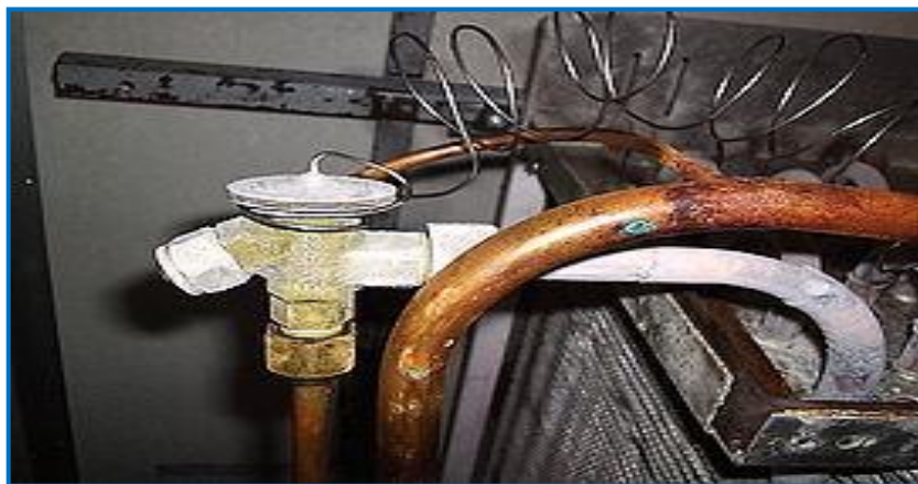
Figura 23. Bulbo de alta y baja presión instalado en válvula termostática
