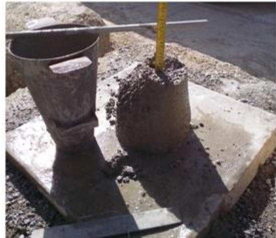
CONCRETO PARA CIMENTACIÓN Y LOSAS
