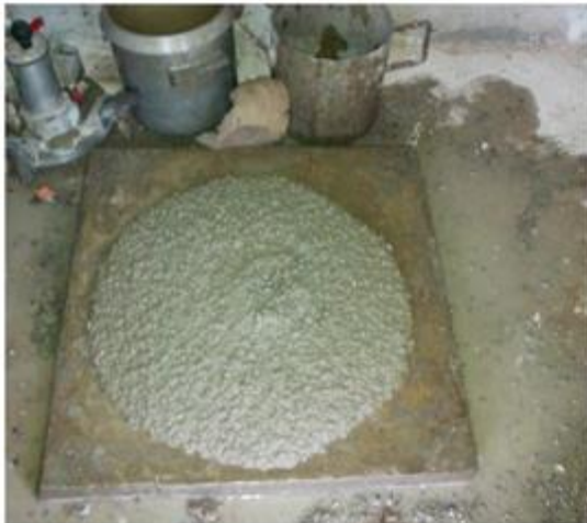
CONCRETO PARA MUROS
