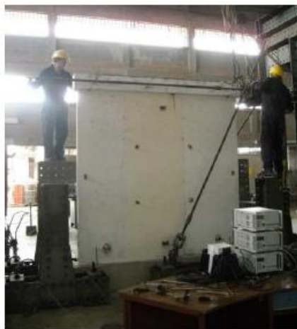
Figura 49. Preparación del muro
