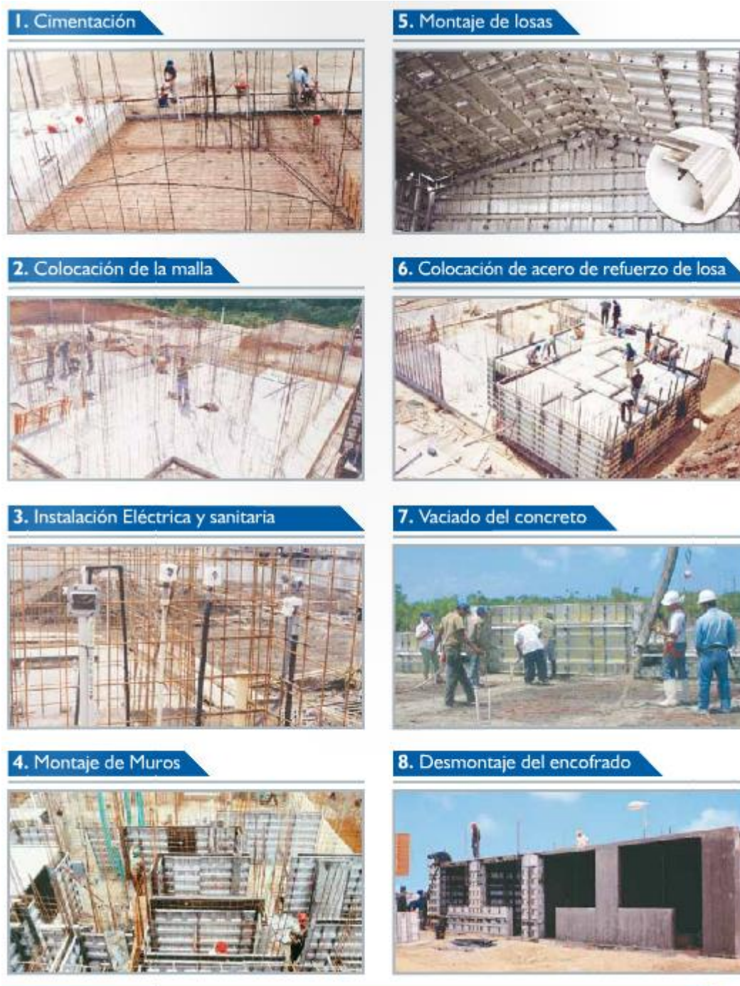
Figura 18. Construcción industrializada en serie
