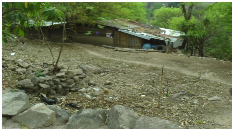
Viviendas en condiciones muy precarias y vulnerables ante cualquier desastre
