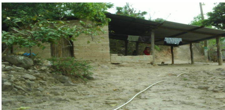
Viviendas en condiciones muy precarias y vulnerables ante cualquier desastre
