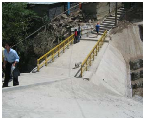
Puente entrada, después
