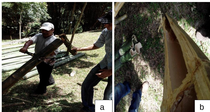
Figura 17. Corte para elaboración de canales de bambú. Fuente: Autor (2015).
