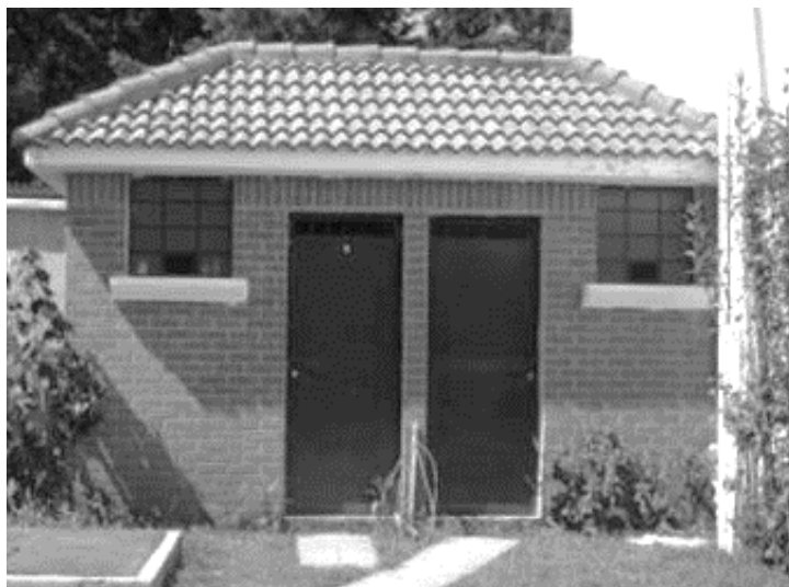
Figura 8. Caseta de control de bombeo
