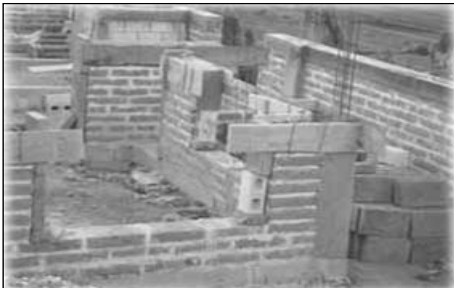
Figura 13. Construcción de adobe
