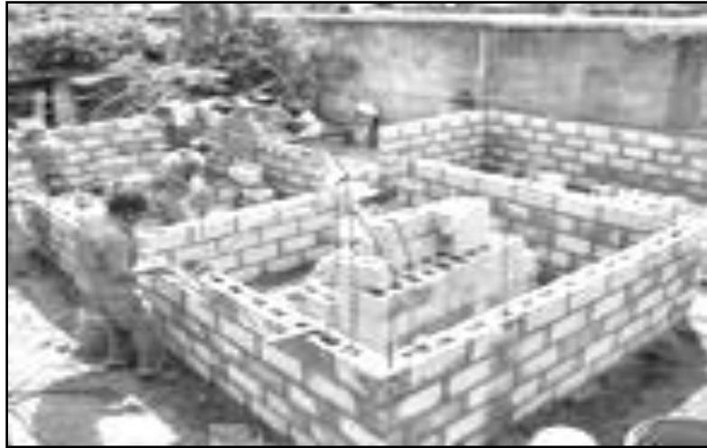
Figura 14. Construcción de mampostería sin refuerzo
