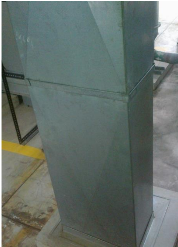
Figura 32. Uniones de ductos
