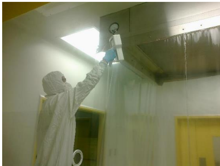
Figura 86. Medición en las juntas de estanqueidad (II)
