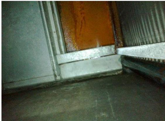
Figura 122. Bandejas de agua con óxido
