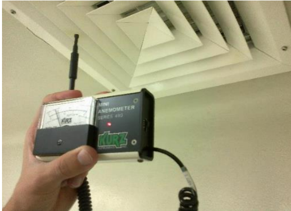
Figura 115. Medición de caudal (II)
