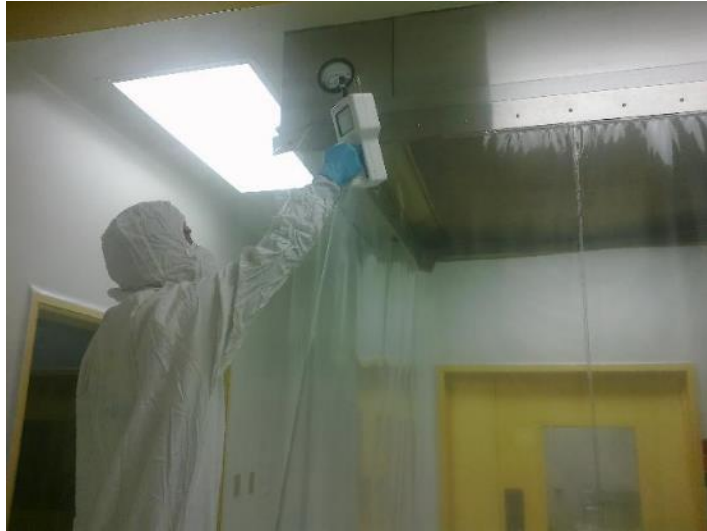
Figura 85. Medición en las juntas de estanqueidad (I)
