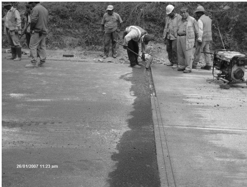
**Figura 30. Detalle de construcción de junta en estructuras existentes caso de estructura de puente, y paso peatonal.**
