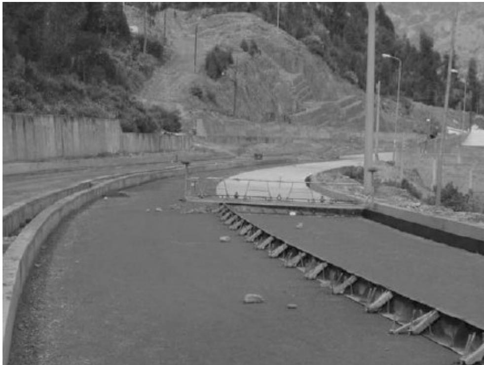
**Figura 26. Fotografía construcción de junta longitudinal sin formaleta**
