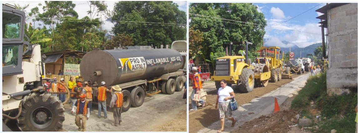
Figura 12. Tren de reciclado en un proyecto de rehabilitación
