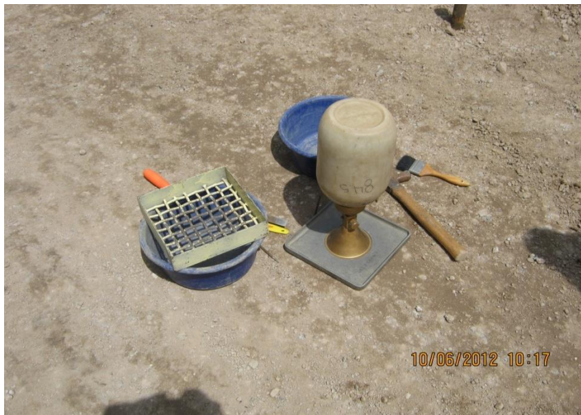
Figura 10. Chequeo de compactaciones para relleno de tubería
