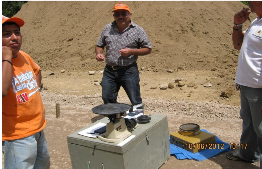
Figura 12. Control de calidad de relleno
