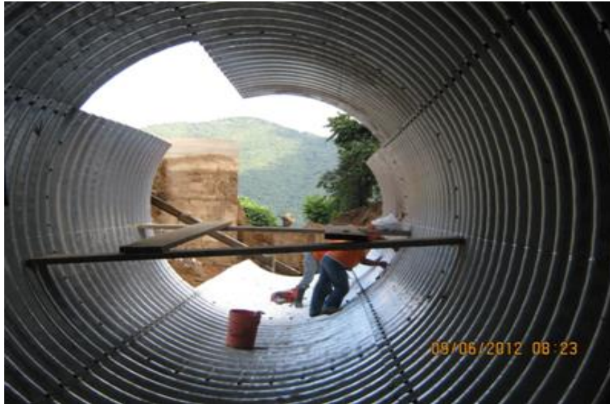
Figura 9. Instalación de bóveda
