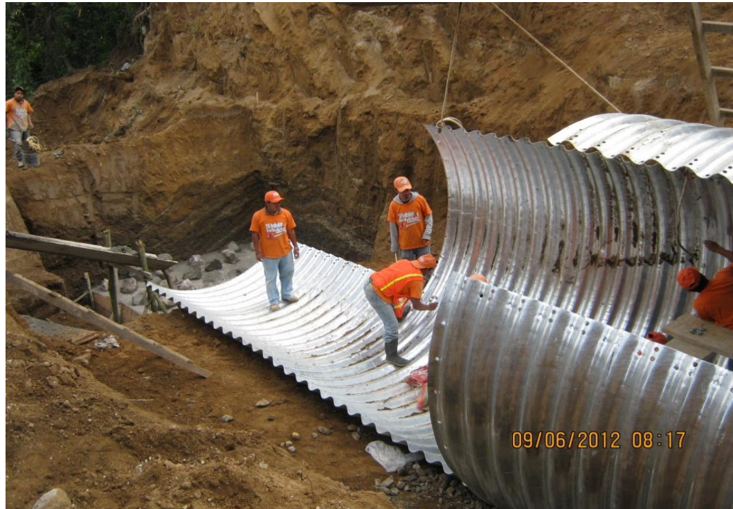
Figura 1. Armado de tubería de diámetro mayor
