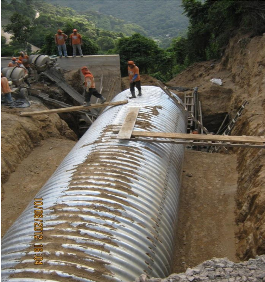
Figura 2. Laterales de media sección de la tubería, ya compactados
