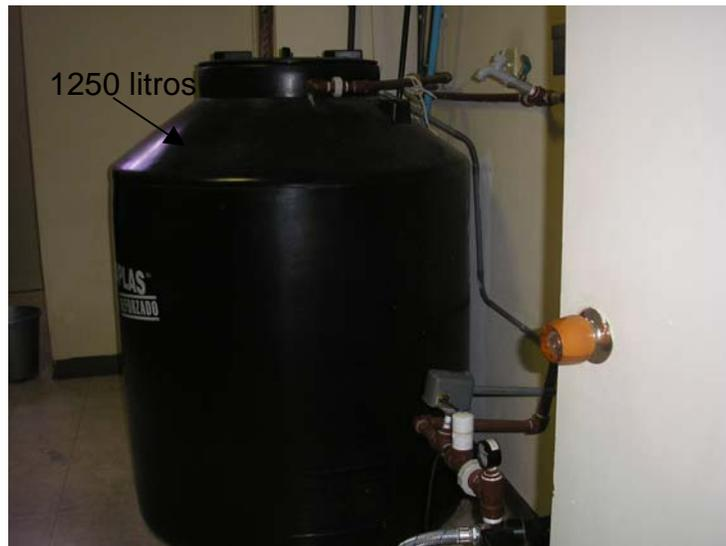
**Figura 13. Origen de la toma de agua para chorro de preparación de líquido de diálisis.**
