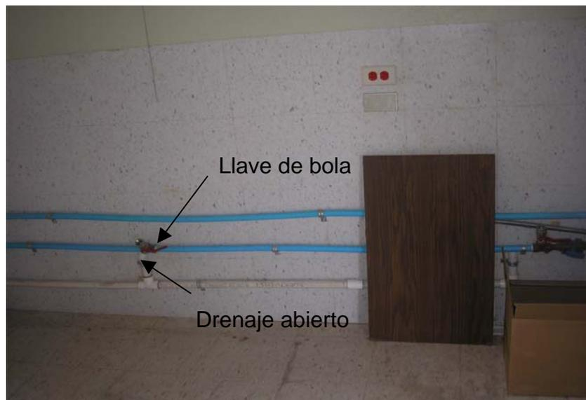
Como se puede observar en la Figura14, el drenaje de las máquinas de hemodiálisis es del tipo abierto lo que no representa un foco de contaminación en dichas máquinas, ya que no pueden ascender las bacterias por la manguera de drenaje, sin embargo el personal técnico con el fin de eliminar la probabilidad de un rebalse ha instalado silicón entre la manguera y el tubo de drenaje convirtiéndolo en uno de tipo cerrado aumentando la probabilidad que las máquinas se
