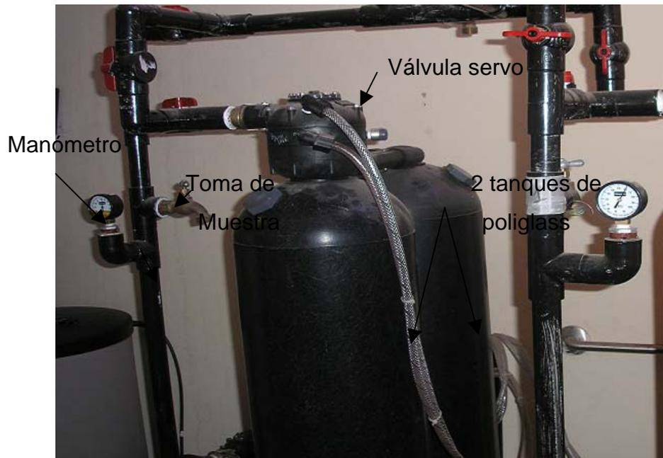
**3.3.1.3 Suavizador (Figura 7) E-03:** para la remoción de la dureza se utiliza un suavizador de agua el cual tiene una capacidad de intercambio de 4,782 granos y que la
