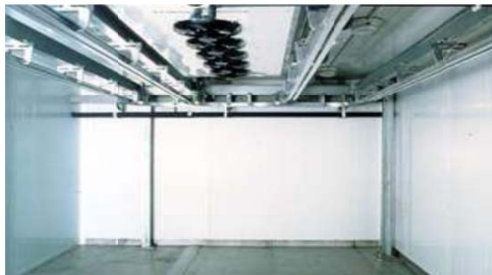
Figura 45. Fotografía de cuarto frío parte interna
