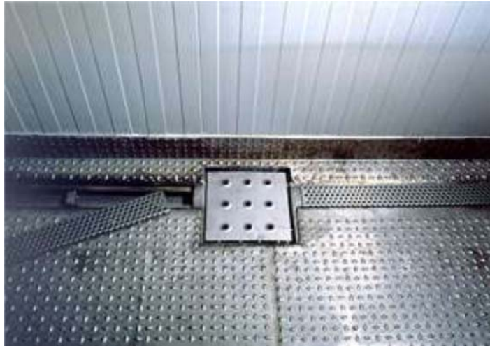
Figura 29. Fotografía de instalación desagüe
