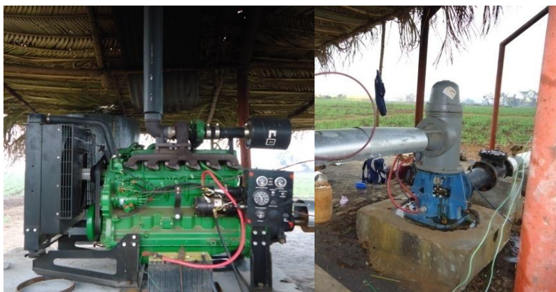
Figura 1. Motor John Deere con sus accesorios instalados
