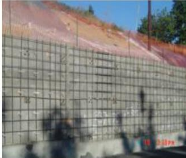
Figura 45. Colocación de electromalla
