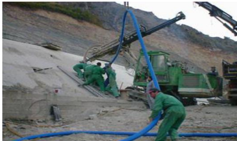
Figura 46. Colocación de pernos e inyección de pernos
