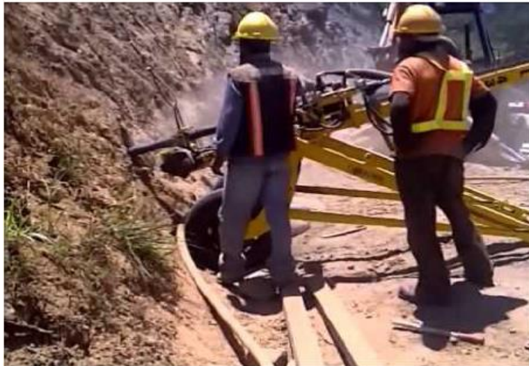
Figura 44. Refuerzo al suelo mediante la instalación de barras de acero
