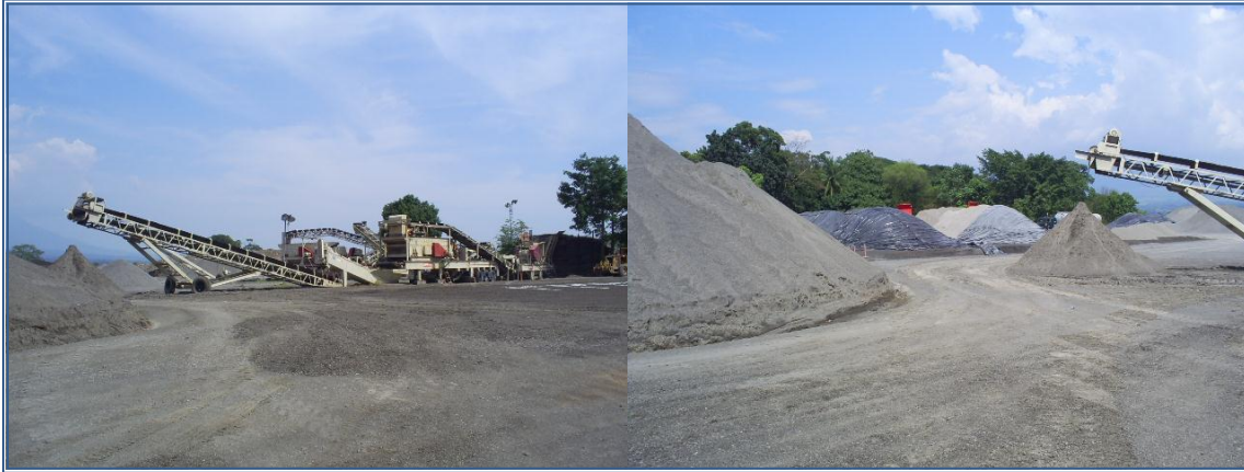
Figura 3. Trituración de agregados naturales en planta de trituración de la empresa Sigma Constructores
