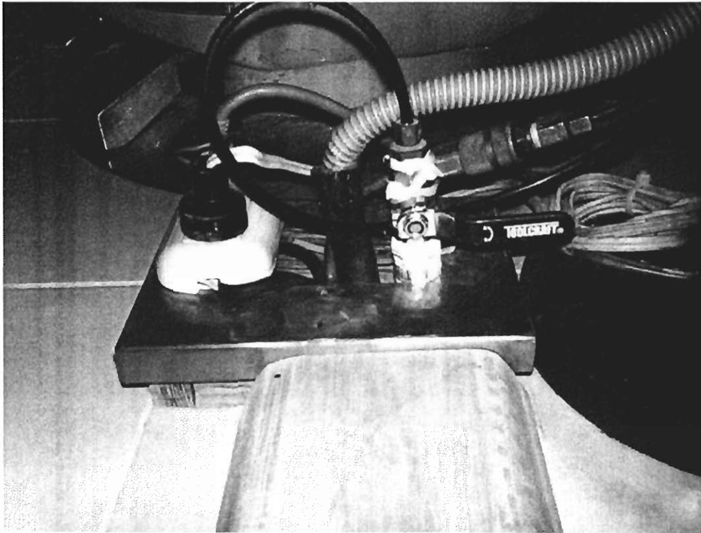
Nuevas instalaciones eléctricas.
