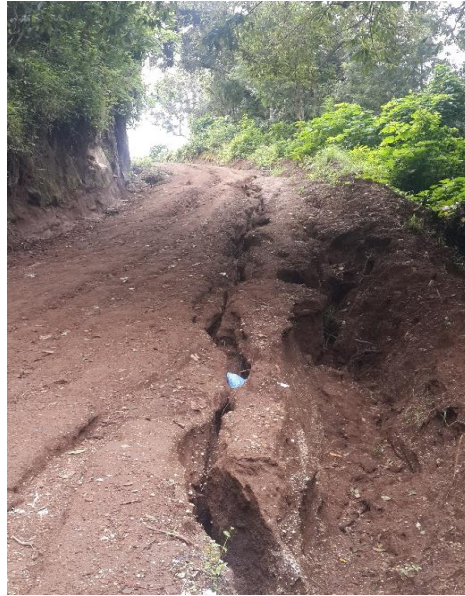
Figura 5. Carretera de acceso hacia El Astillero
