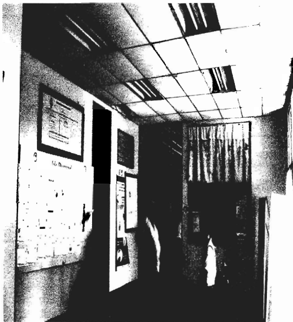
Aspecto anterior a la realización del proyecto
