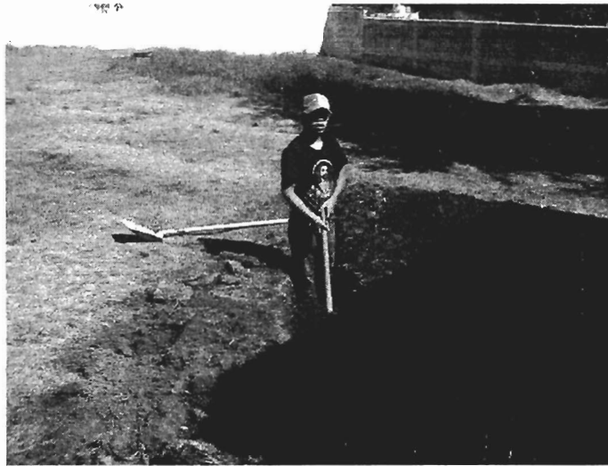
Zanjeado para encontrar drenaje principal para unirlo a drenaje del lavabo
