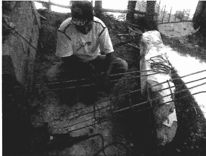
Armado de la estructura principal
