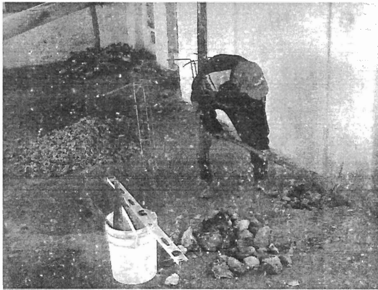
Ubicación del proyecto e instalación de bases del lavabo
