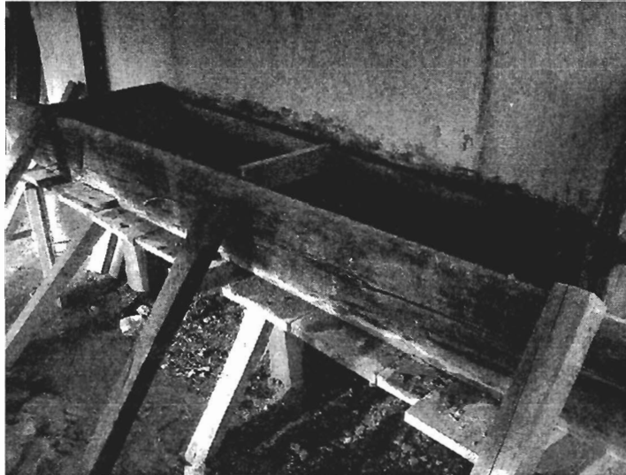
Fundición de pileta para lavabo
