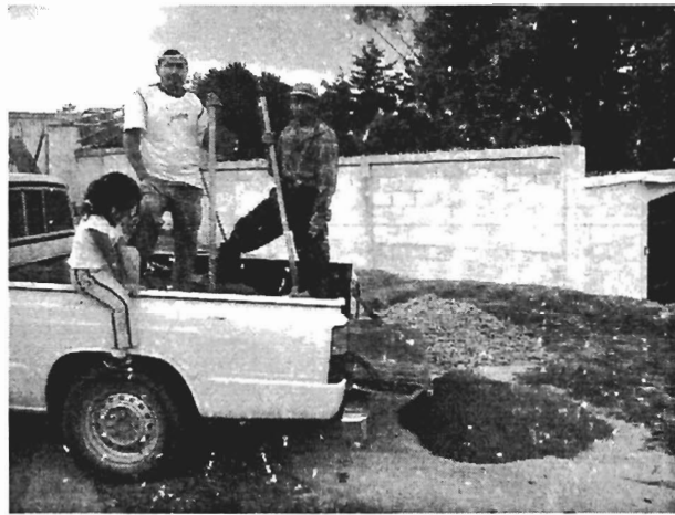
Albañiles descargan el material
