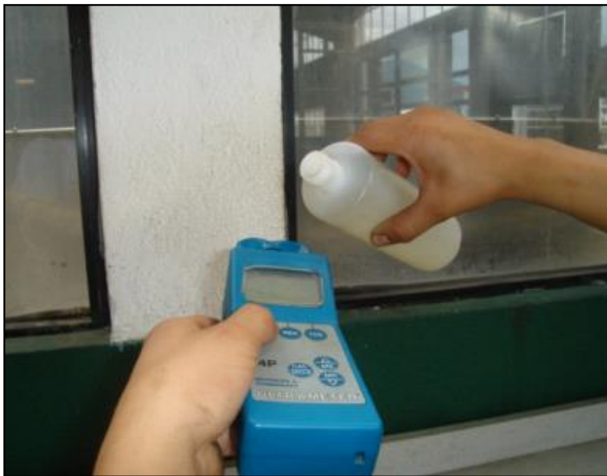
Figura 95. Forma correcta de vertido de agua en conductivimetro
