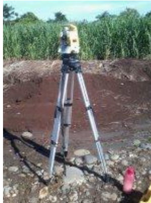
Figura 6: estación total lista para el levantamiento de altimetría Fuente: Autor (2014)
