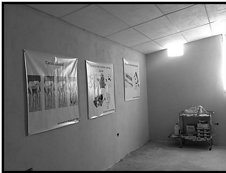
Fotografía No. 13: Vista final 2, del sitio a remodelar, en el área anexa a la Clínica, del Hospital Nacional Infantil “Elisa Martínez”, Puerto Barrios, Izabal.
