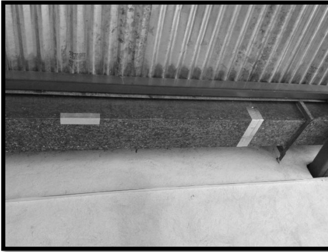
Fotografías No. 4 y 5: Reparación de goteras, en los canales colocados dentro del sitio a remodelar, en el área anexa a la Clínica, del Hospital Nacional Infantil “Elisa Martínez”, Puerto Barrios, Izabal.
