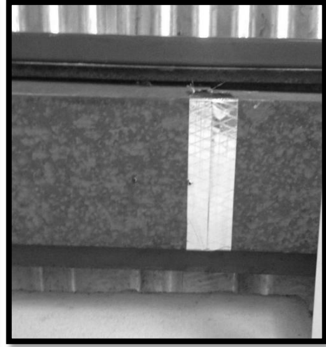
Fotografías No. 4 y 5: Reparación de goteras, en los canales colocados dentro del sitio a remodelar, en el área anexa a la Clínica, del Hospital Nacional Infantil “Elisa Martínez”, Puerto Barrios, Izabal.
