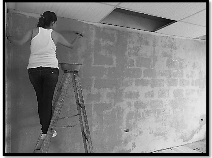
Fotografías No. 8 y 9: Aplicación de pintura en muros del sitio a remodelar, en el área anexa a la Clínica, del Hospital Nacional Infantil “Elisa Martínez”, Puerto Barrios, Izabal.
