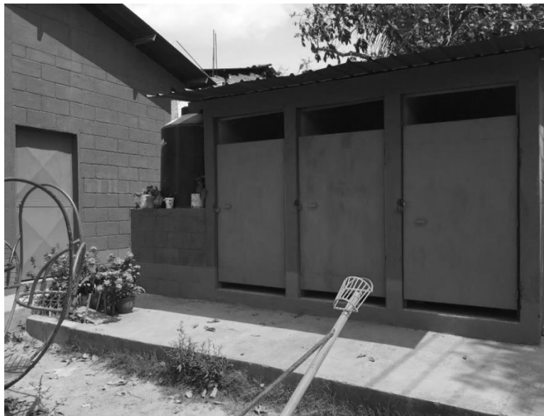
Imagen 5. Área de baños terminada de pintar.
