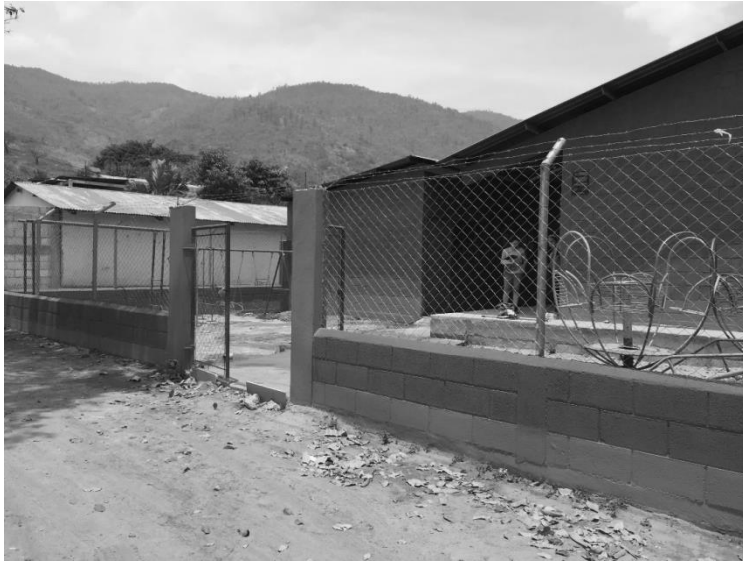
Imagen 6. Vista externa de la escuela de los Mangales terminada de pintar.
