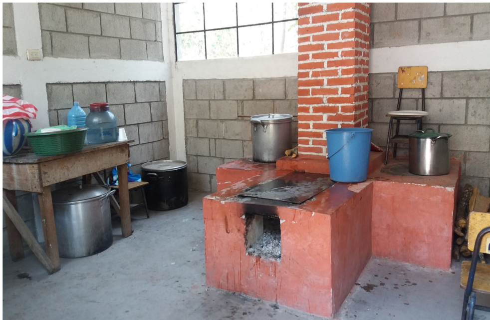
Interior construcción cocina escolar EORM Choliva
