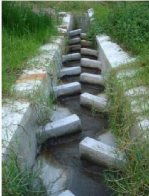
Figura 16. Canal pantallas deflectoras
