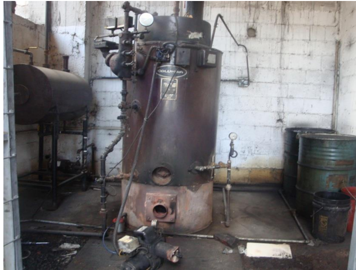
Figura 8. Caldera pirotubular
