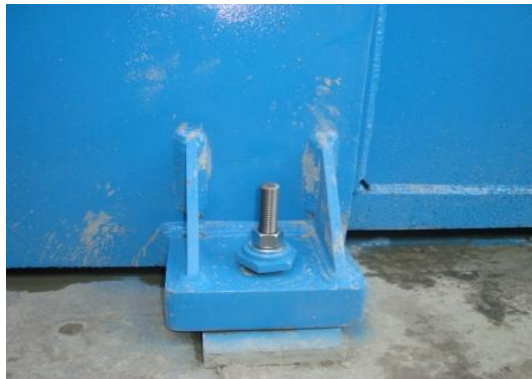
Figura 46. Anclaje de maquinaria
