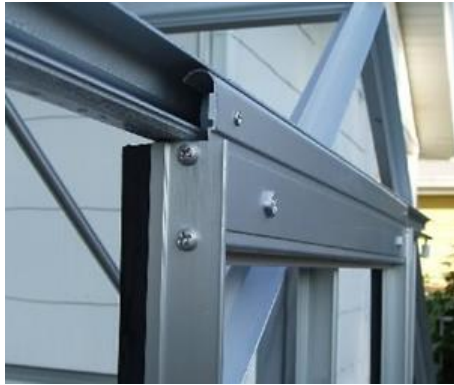
Figura 45. Unión por tornillo
