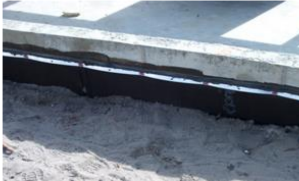
Figura 47. Aislamiento de vibraciones mediante elastómeros
