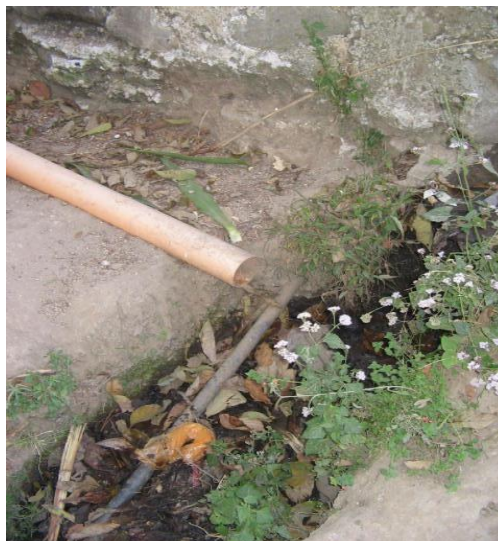
Figura 6. Tubería de aguas residuales
