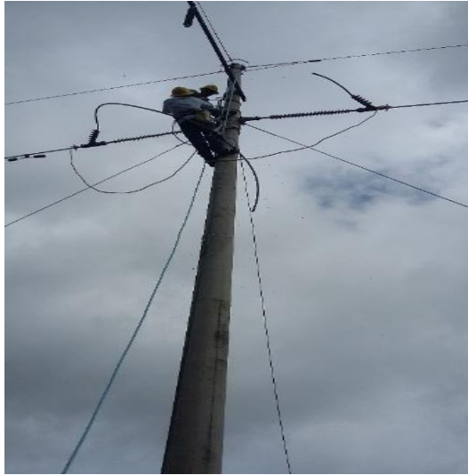
Figura 43. Corte del conductor para cambio de empalme
