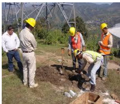
Figura 49. Corrección de tierra física
