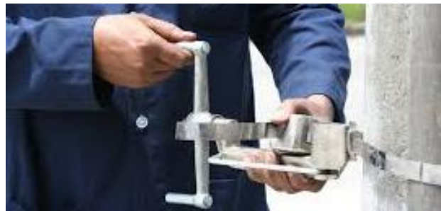
Figura 46. Colocación de cinta band-it con flejadora
