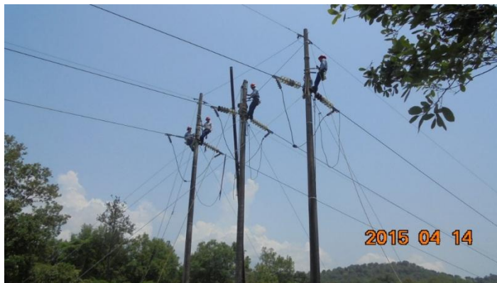
Figura 39. Descenso del crucero de la estructura
