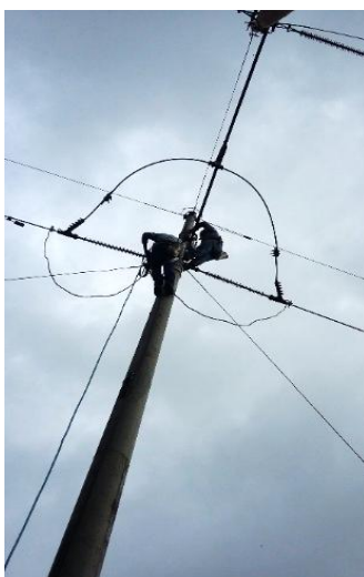
Figura 45. Cambio de empalme finalizado
