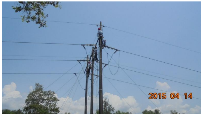
Figura 38. Removiendo la tornillería del crucero
