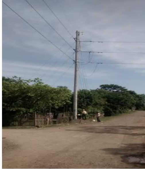
Figura 8. Estructura de remate ángulo 90 grados
