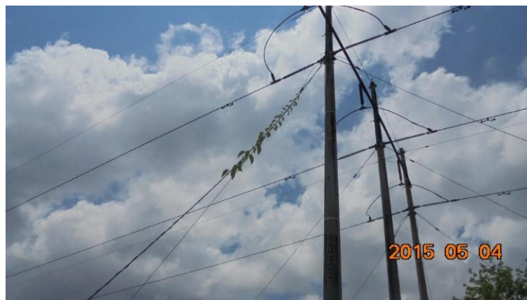
Figura 9. Estructura de remate ángulo de 0 grados
