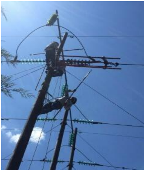
Figura 35. Instalación del yugo trasero del bastidor doble
