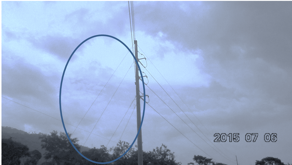
Figura 7. Estructura de ángulo
