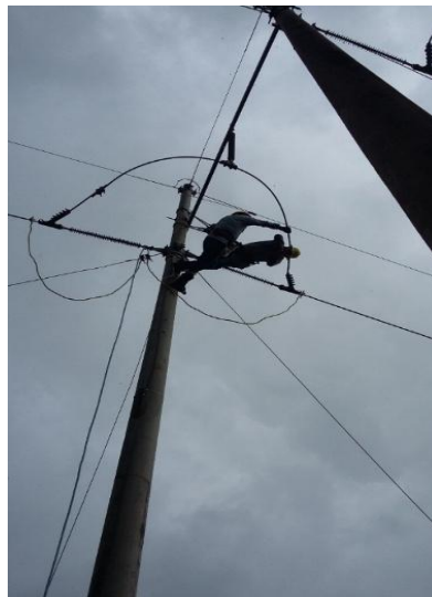
Figura 44. Linieros realizando el empalme
