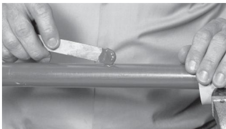
Figura 55. Reparación de pequeña fisura
