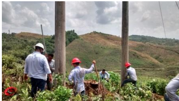
Figura 51. Excavación de los agujeros a un costado de los postes
