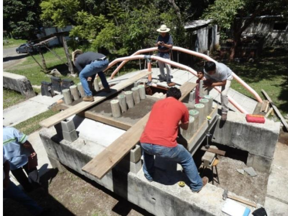
Figura 19. Colocación de cilindros de concreto
