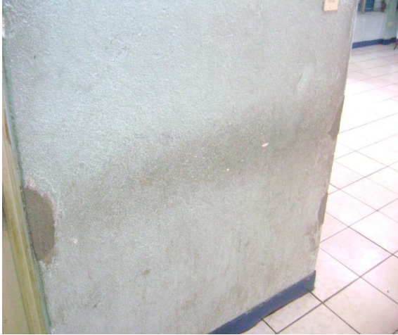
Preparación de las paredes
