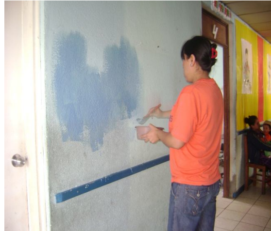
Ejecución del proyecto
