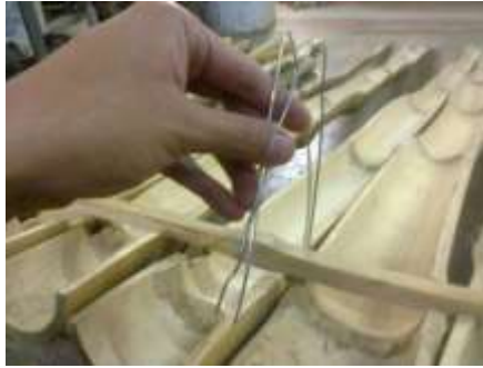
Figura 52. Colocación de alambre galvanizado para anclaje
