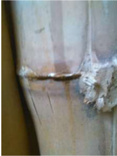
Figura 28. Filtración por rajadura en nudo
