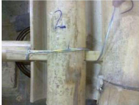
Figura 61. Caña de bambú debidamente ensamblada con pasador
