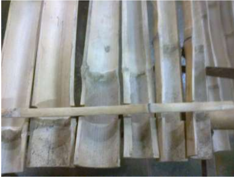
Figura 51. Ensamble de pasador
