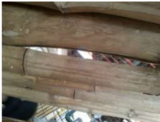
Figura 29. Abertura por curvatura de la caña de bambú
