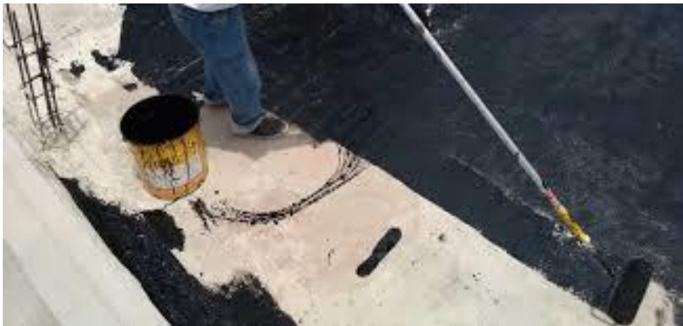
Figura 33. Aplicación de emulsión asfáltica a base de agua
