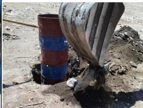
Figura 8. Instalación de chimeneas
